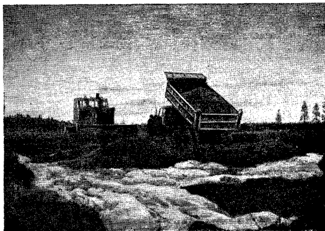
Рис. 4. Укладка нетканого материала и засыпка его грунтом
