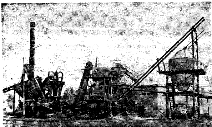
Асфальтобетонные заводы: слева с термос-бункером емкостью 100 т и кирпичным складом минерального порошка емкостью 1500 т, справа — с силосным складом минерального порошка (4 силоса по 70 т)
