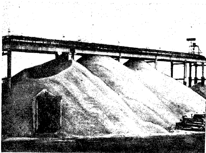
Склад щебня с галереей конвейеров
