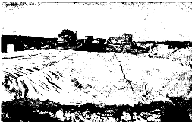
Рис. 2. Засыпка полотнищ бидима грунтом
