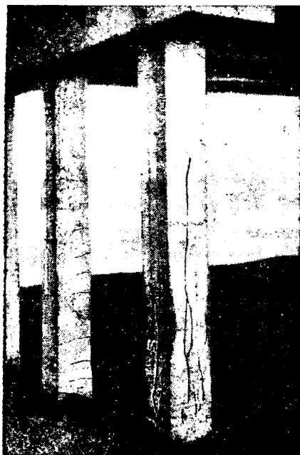
Рис. 3. Расположение вертикальных трещин в монолитной свае
