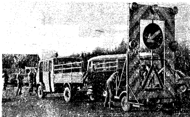
Рис. 1. Предупредительный щит перед ремонтируемым участком дороги
