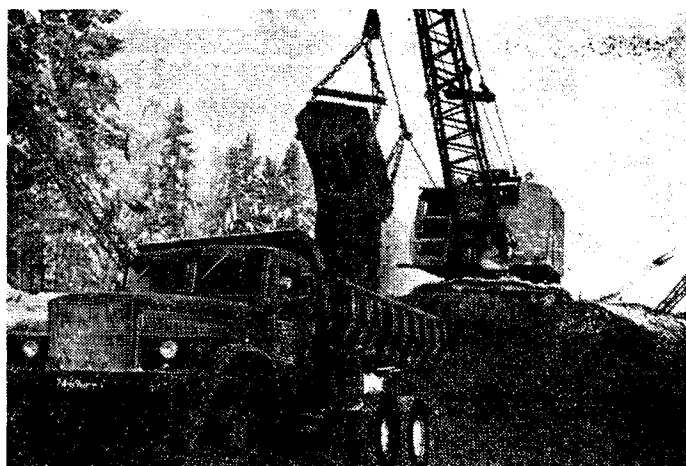
Рис. 1. Разработка и погрузка гравийно-песчаной смеси экскаватором Э-652, оборудованным драглайном
