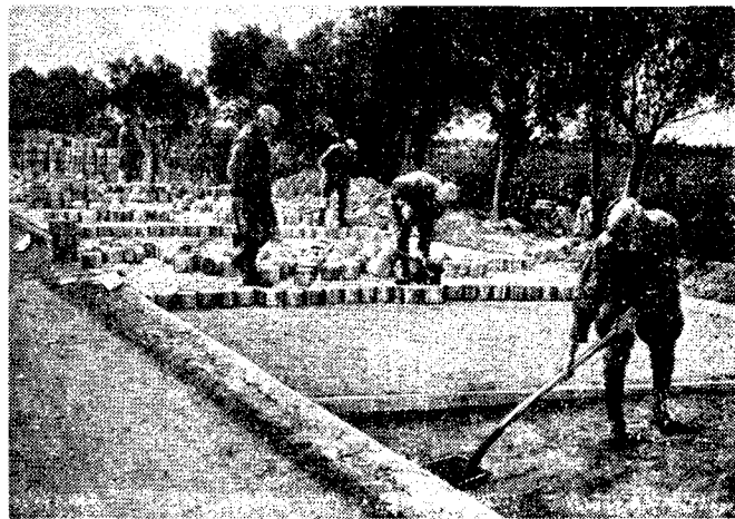
1942—1943 гг. Устройство торцовой деревянной мостовой на одной из дорог Волховского фронта
