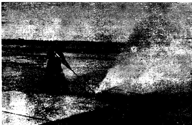
Рис. 1. Использование энергии воды для обработки трещин перед ремонтом бетонного покрытия
