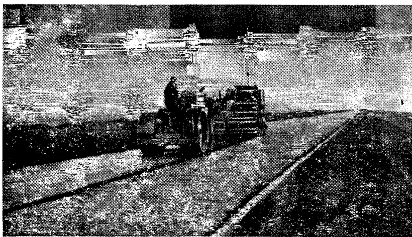
Укладна асфальтобетонной смеси на участке Торбеево — Новые Выселки. Работы ведет специализированная бригада ДСУ-2.
