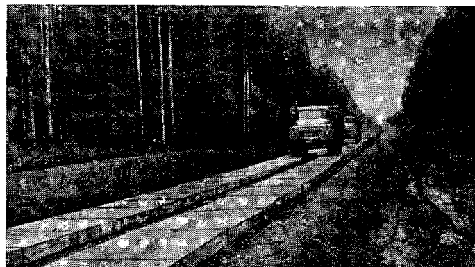
Рис. 3. Общий вид опытного участка дороги с колеиным покрытием из силикатобетонных плит
