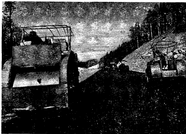
Устройство нижнего слоя покрытия на пусковом участке дороги Куйбышев—Уфа—Челябинск. Работы ведет СУ-820 треста Уфимдорстрой
