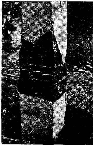
Свая до и после ремонта
