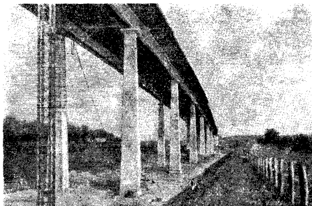
Рис. 5. Вид строящегося моста на острове Радер
