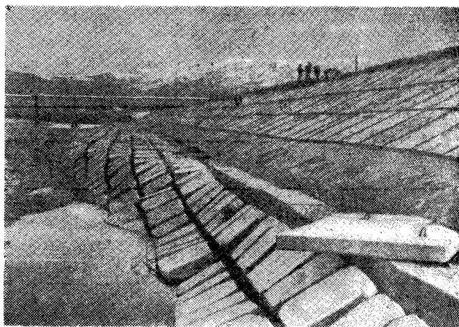
Рис. 1. Разрушение гибкого тюфяка на мостовом переходе через р. Кафирниган
