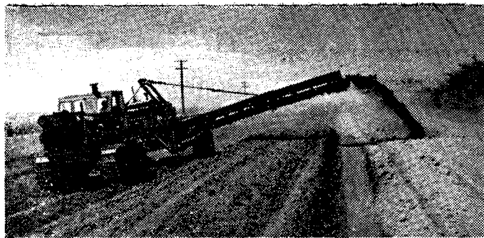
Устройство грунто-шлакоцементного основания дороги Новопокровка — Лошкаревка в Солонянском районе Днепропетровской обл. (слева — досыпка грунта, справа — введение цемента).
