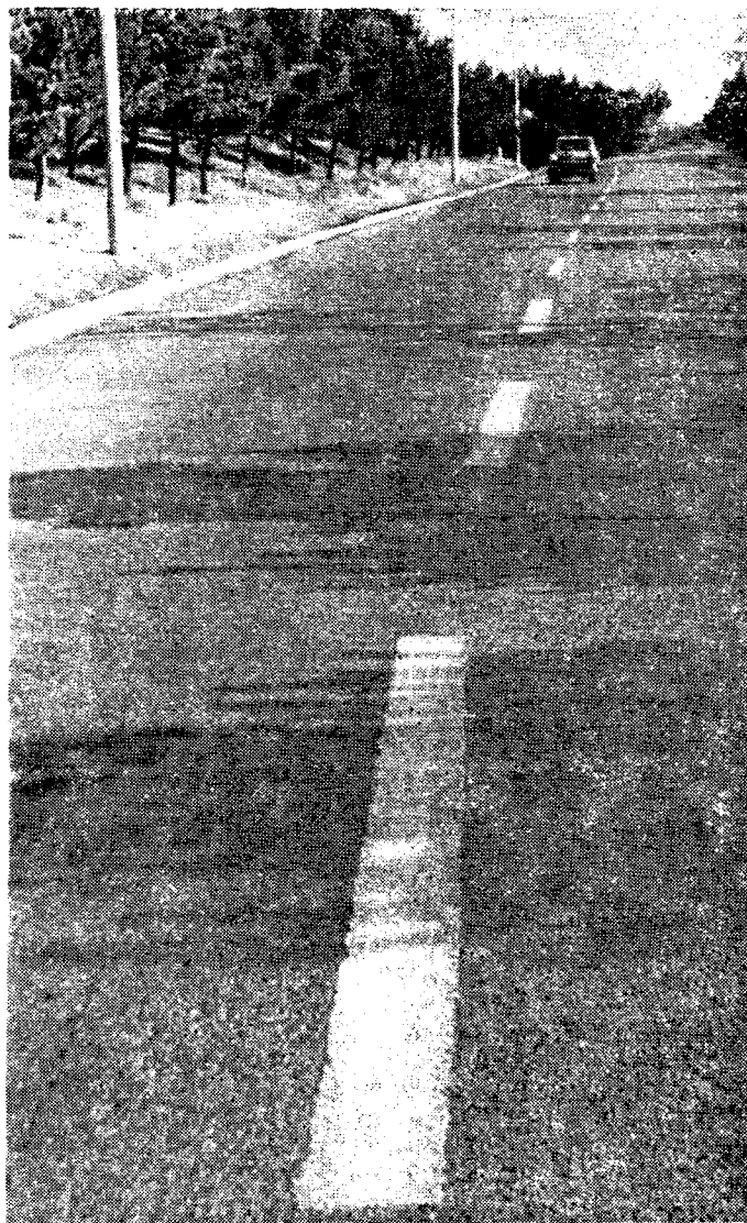
Регулировочные линии, устроенные из белого дробленого известняка способом одиночной поверхностной обработки на дороге Тбилиси — Манглиси — Богдановка
