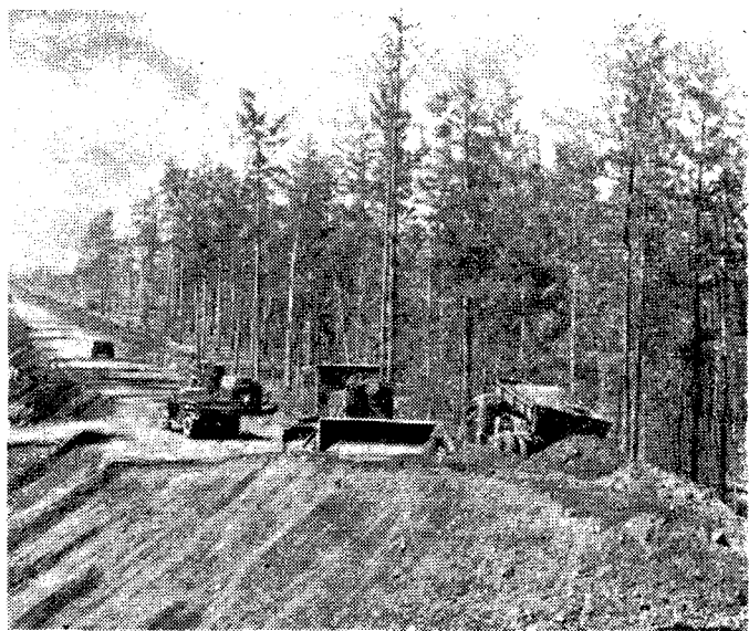
Возведение земляного полотна на одной из строящихся дорог в Мордовской АССР
