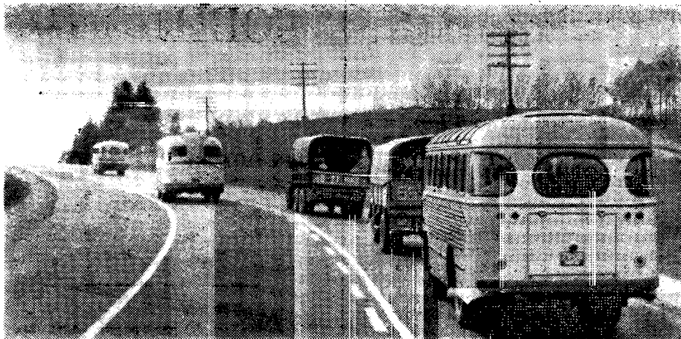
Регулировочные линии на дороге Москва—Куйбышев
