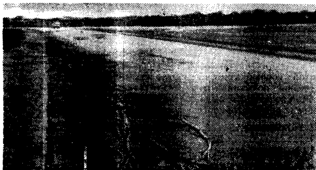
Рис. 1. Пучинистый участок на дороге в Ивановской обл.
