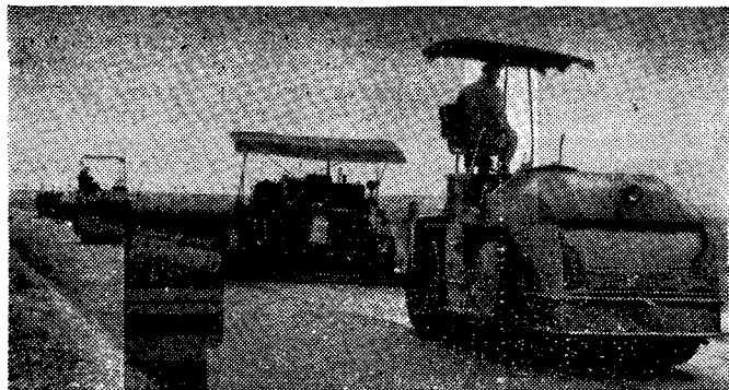
Устройство асфальтобетонного покрытия на дороге Новопавловская — Курская
