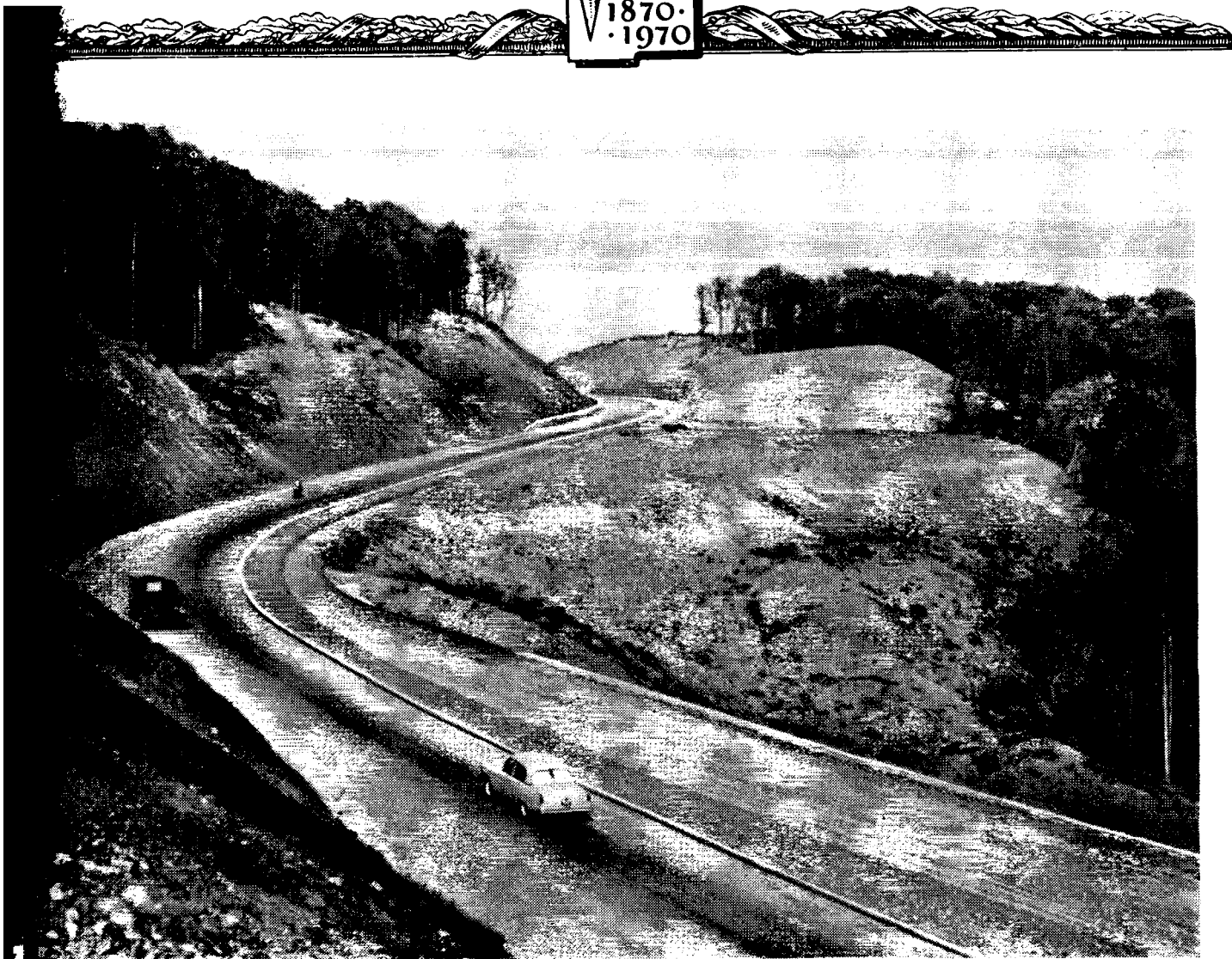
Строительство горного участка дороги Горячий Ключ — Джубга (справа устроено основание)
