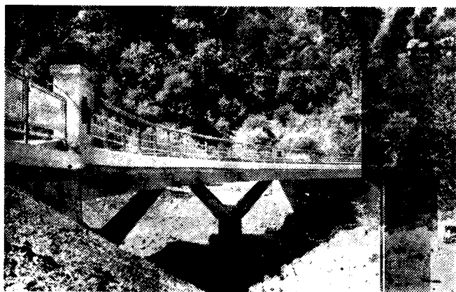
Рис. 4. Рамно-неразрезной мост на кривой в плане (на дороге Алма-Ата — Медео)
