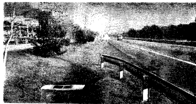
Дождеприемный колодец на разделительной полосе и деталь металлического ограждения
