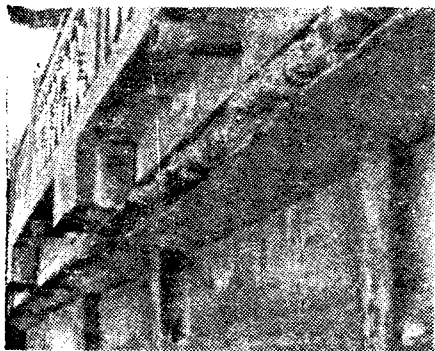
Рис. 2. Разрушение бетона крайней балки эстакады после 15 лет эксплуатации
