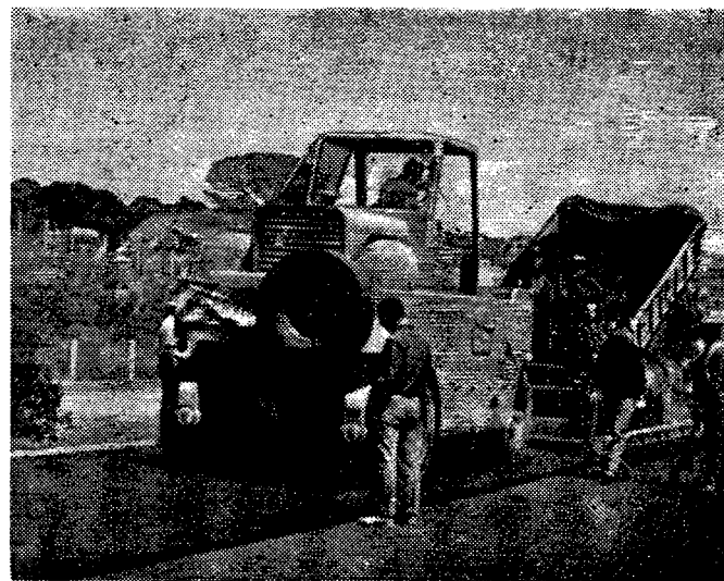
Рис. 1. Укладка асфальтобетонного покрытия
