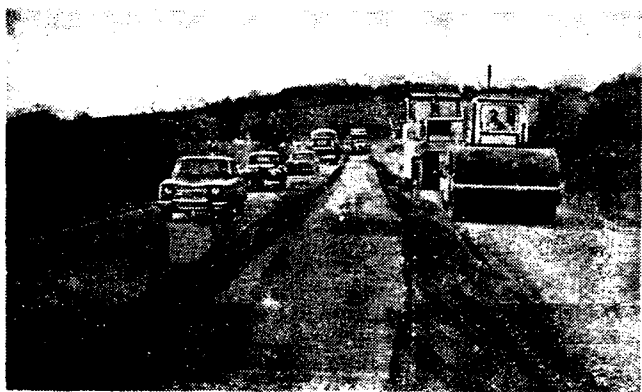
Рис. 3. Открыто движение по свежесложенному слою основания
