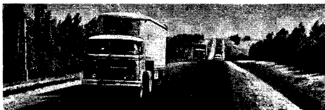
Неудачное проектирование продольного профиля
