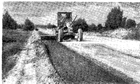
Рис. 3. Укладка смеси в корыто и профилирование
