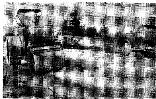
Рис. 4. Уплотнение цементогрунта
