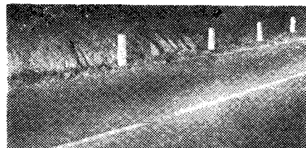
Регулировочная линия из халцедона (отрезок на переднем плане) отчетливо видна ночью при свете фар автомобиля
