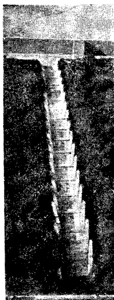
Рис. 3. Для водосточа применены телескопические конструкции лотков
