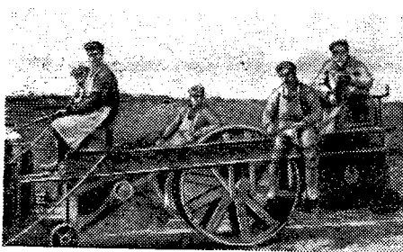
Конный прицепной вальцовый каток (начало XX века)
