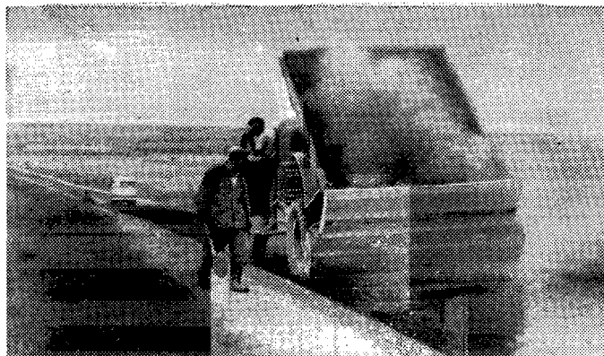
Устройство шероховатой поверхностной обработки с применением черного горячего щебня на дорогах Луховицкого района
