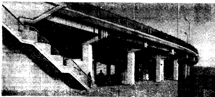
Фрагмент эстакады на криволинейном участке с лестницами для пешеходов
