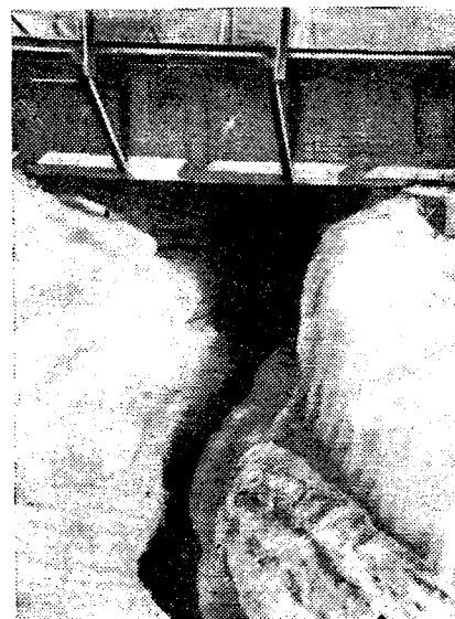
Рис. 1. Наледь почти полностью закрыла отверстие моста
