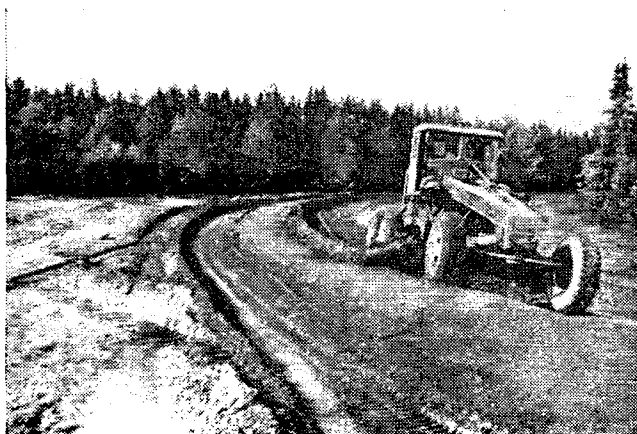
Подготовка грунта основания и обработке цементом
