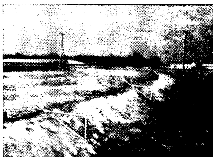
Рис. 3. Установка инвентарных откосников при возведении земляного полотна
