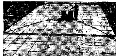
Рис. 2. Общий вид (а) и схема (б) электротермического нагрева стержней:
