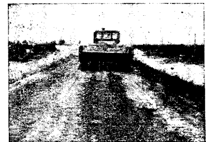
Так было организовано устройство цементогрунтовых оснований и покрытий в Белоруссии
