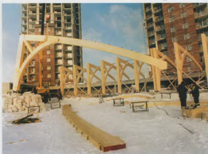
Рис. 7. Монтаж деревянных рам
