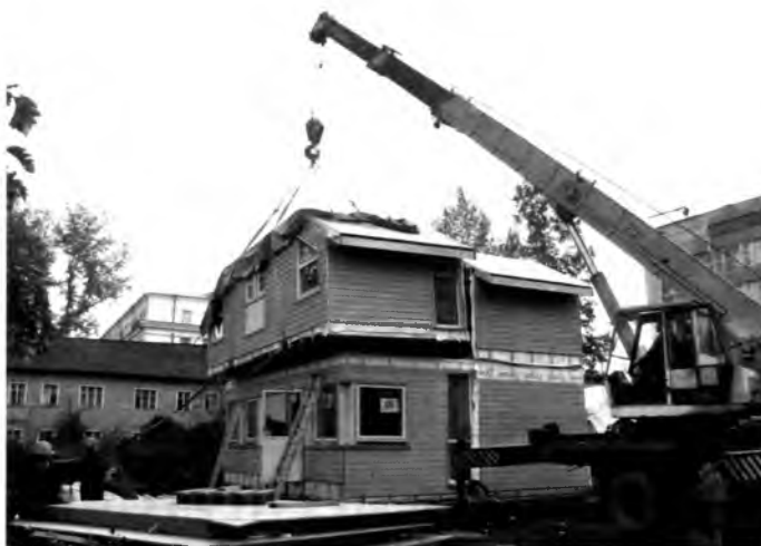
Рис. 2. Монтаж модульного здания на готовом фундаменте
