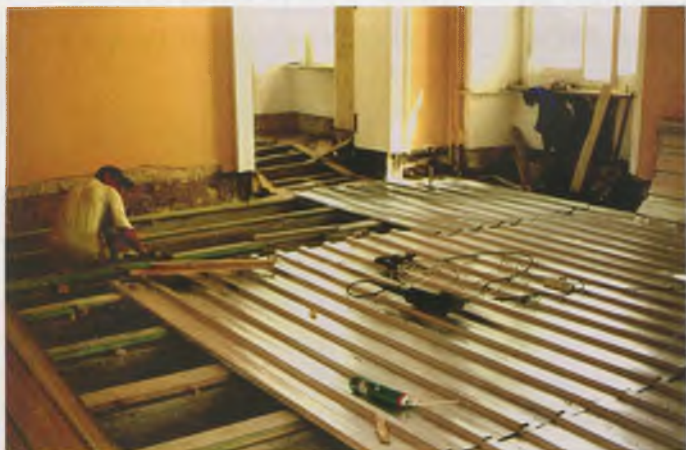
Рис. 5. Усиление деревянных балок перекрытия
