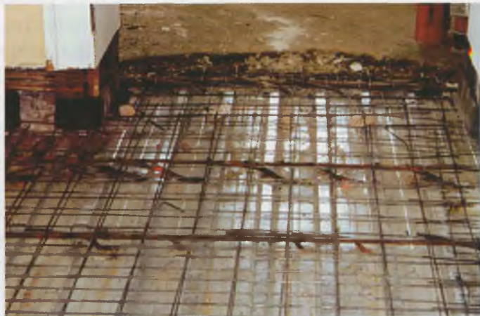
Рис. 6. Устройство железобетонной плиты
