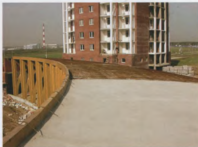
Рис. 8. Бетонная плита в составе ригеля рам
