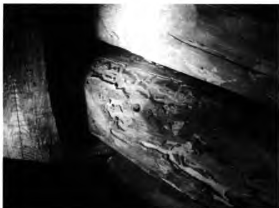
Рис. 7. Следы лубоедов на поверхности конструктивных элементов
