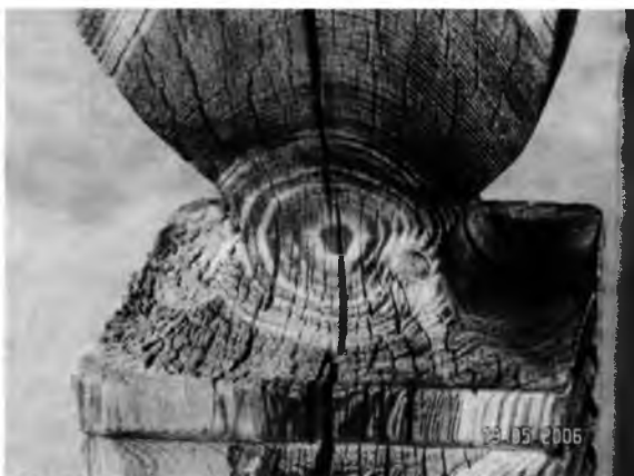
Рис. 2. Эродированная поверхность элемента крыльца Покровской церкви Кижского погоста (1764 г.)
