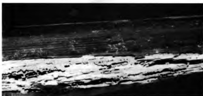
Рис. 8. Плаха потолка, разрушенная жуком-точильщиком
