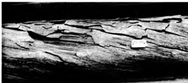
Рис. 4. Типичные трещины в брёвнах сруба Преображенской церкви (1714 г.)
