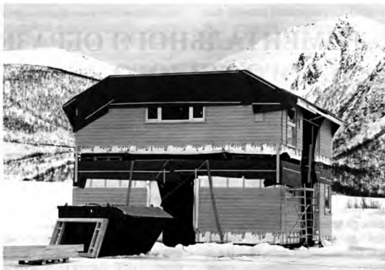
Рис. 2. Шесть модулей для возведения экспериментального образца деревянного дома описанной конструкции
