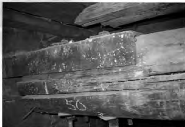
Рис. 4. Дефектный опорный узел
