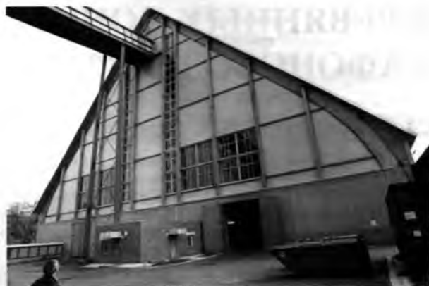
Рис. 5. Склад для хранения минеральных удобрений, построенный с использованием КДК
