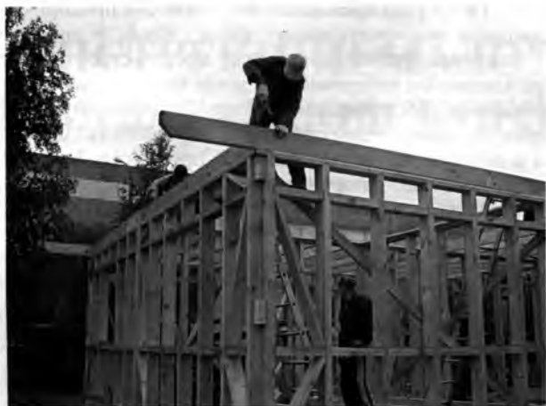
Рис. 6. Возведение каркаса стен дома по системе “Макудом”
