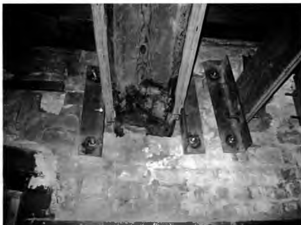
Рис. 5. Усиление консольных балок
