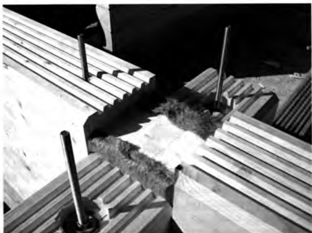
Рис. 10. Стандартное угловое соединение брусового дома
