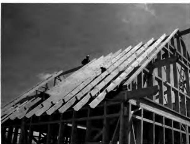
Рис. 7. Возведение фронтонов, стропил дома по системе “Макудом”
