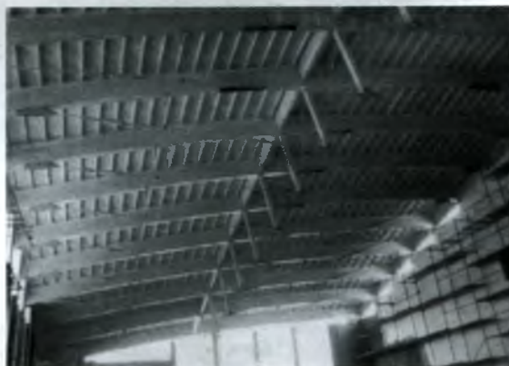
Рис. 2. Элементы крыши складского помещения
