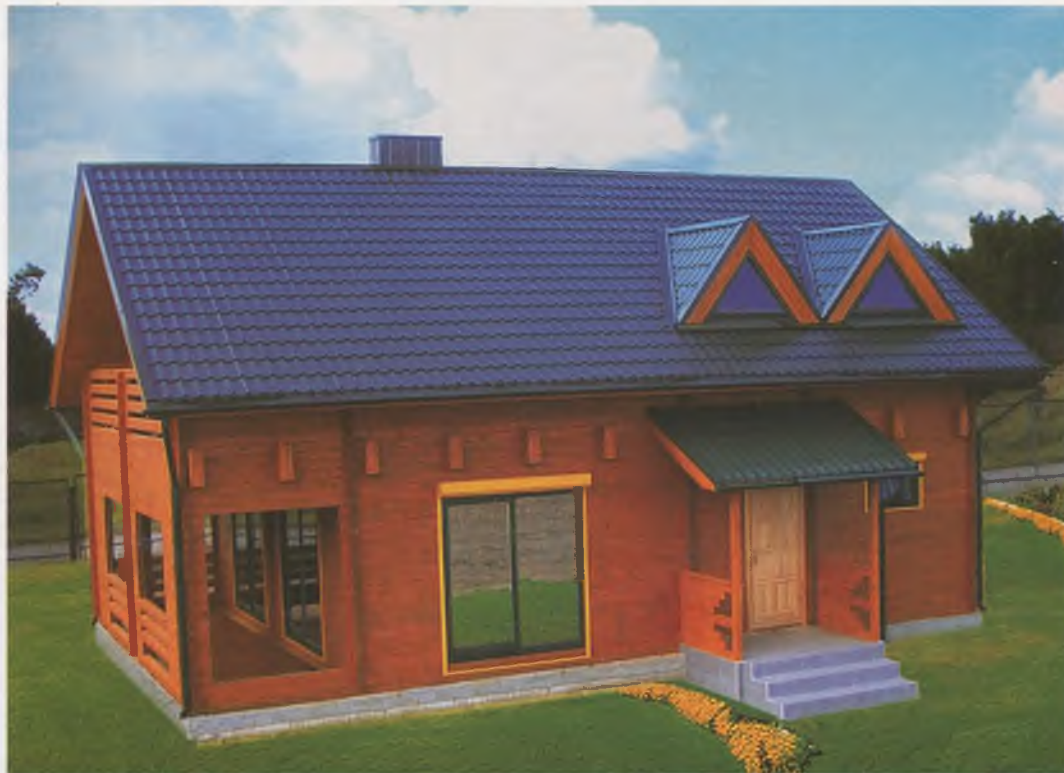
Рис. 14. Дом, собранный с использованием комплекта строительных элементов из клеёного бруса, полученного на оборудовании фирмы “МАИ”
