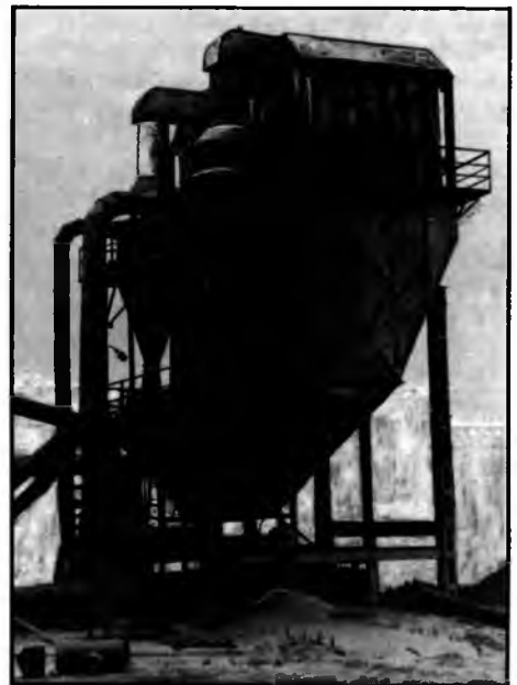
Рис. 3. Пылеулавливающие установки с рукавными фильтрами
