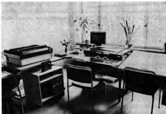
Рис. 3. Лаборатория САПР. Используется печатающее устройство с графическим изображением, ЭВМ и аналого-цифровой преобразователь
