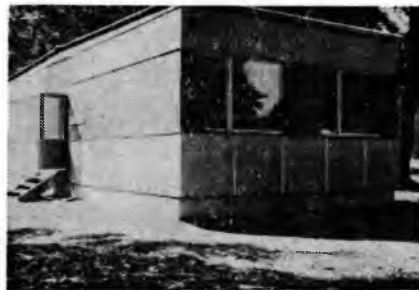
Общий вид одного из сборных сооружений
