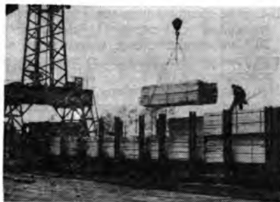
Погрузка пакетов пиломатериалов башенным краном на платформу-сортиментовоз
