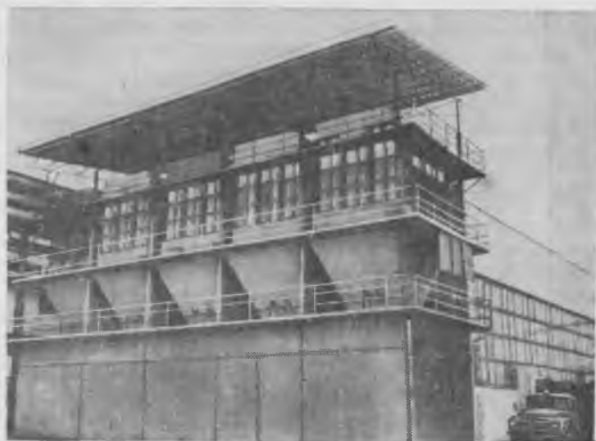
Рис. 2. Установка для сухой сепарации пыли на базе рукавных фильтров ФТНС-12М
