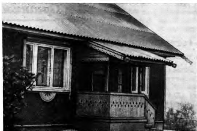
Рис. 5. Крыльцо и оконные наличники
