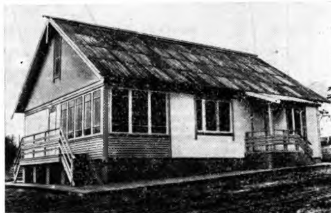
Рис. 1. Трехкомнатный деревянный панельный жилой дом-представитель
