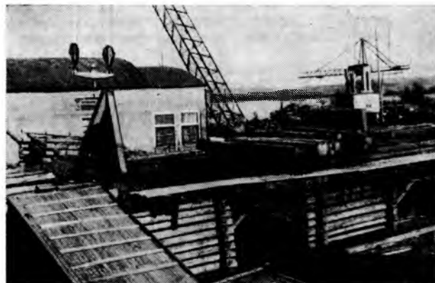
Рис. 2. Грузовая платформа бремсберга для выгрузки пачек хлыстов
