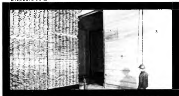
Сушилка пиломатериалов; производительность 20 000 м 3 /камера/год. На снимке подача сушильного пакета в камеру.
