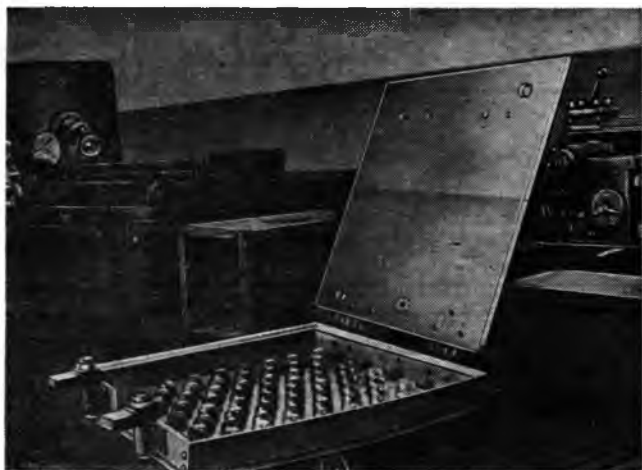
Рис. 2. Сборная пресс-форма для изготовления мягких элементов кресла для отдыха КР-161
