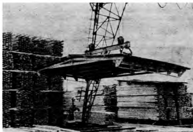
Рис. 3. Укладка инвентарной крыши на штабель краном ККУ-7,5
