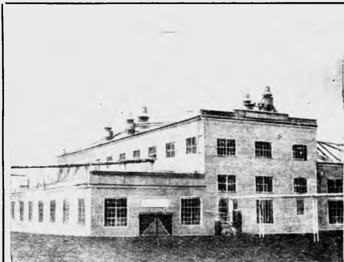
Цех стружечных плит Апшеронского деревообрабатывающего комбината (Краснодарский совнархоз), пущенный в эксплуатацию в текущей семилетке
