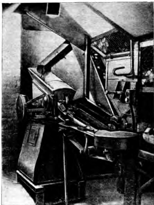
Рис. 2. Коробкоразборный автомат, заблокированный с этикетировочной машиной
