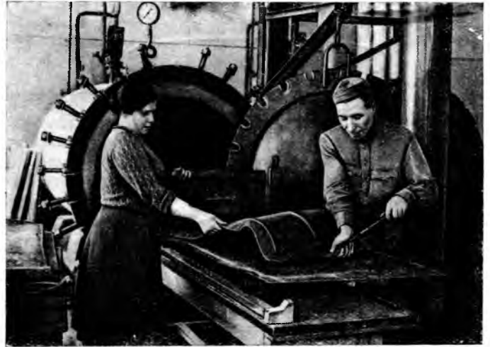
Рис. 5. Запрессовка пакета в резиновом мешке под вакуумом перед автоклавным прессованием
